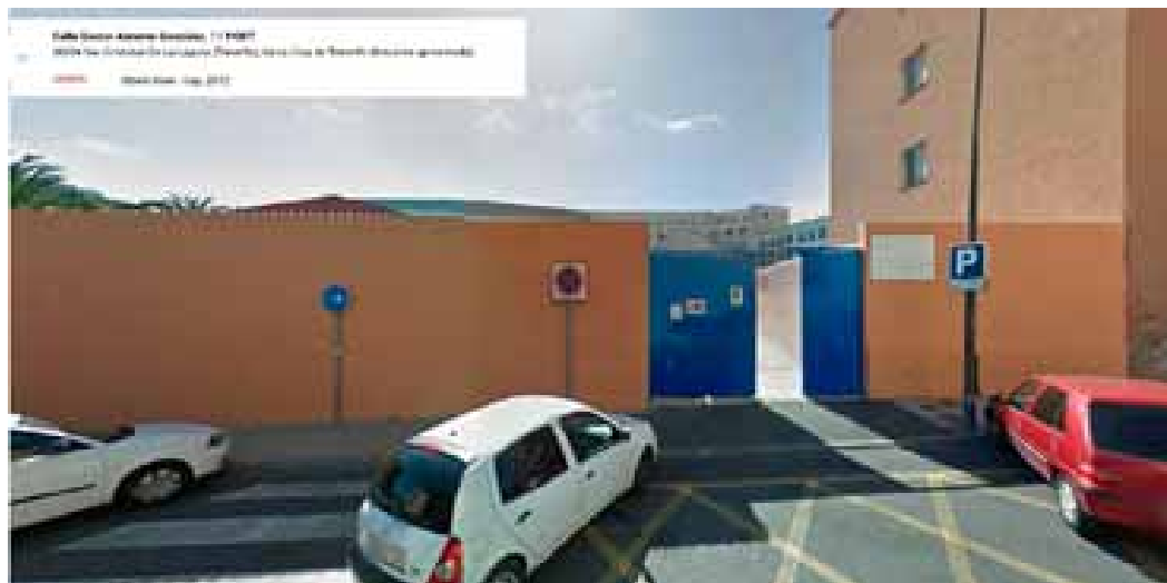
Vista de la calle Dr. Antonio González y de la puerta del colegio antes de nuestro proyecto.
